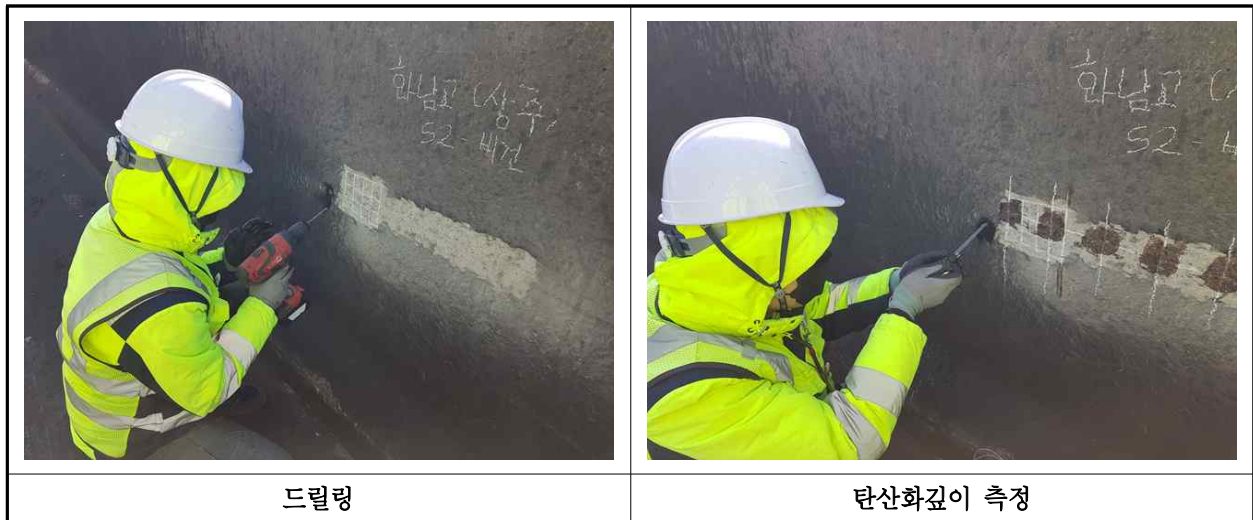
【사진 1.4.3】 탄산화 깊이 측정 현장사진
