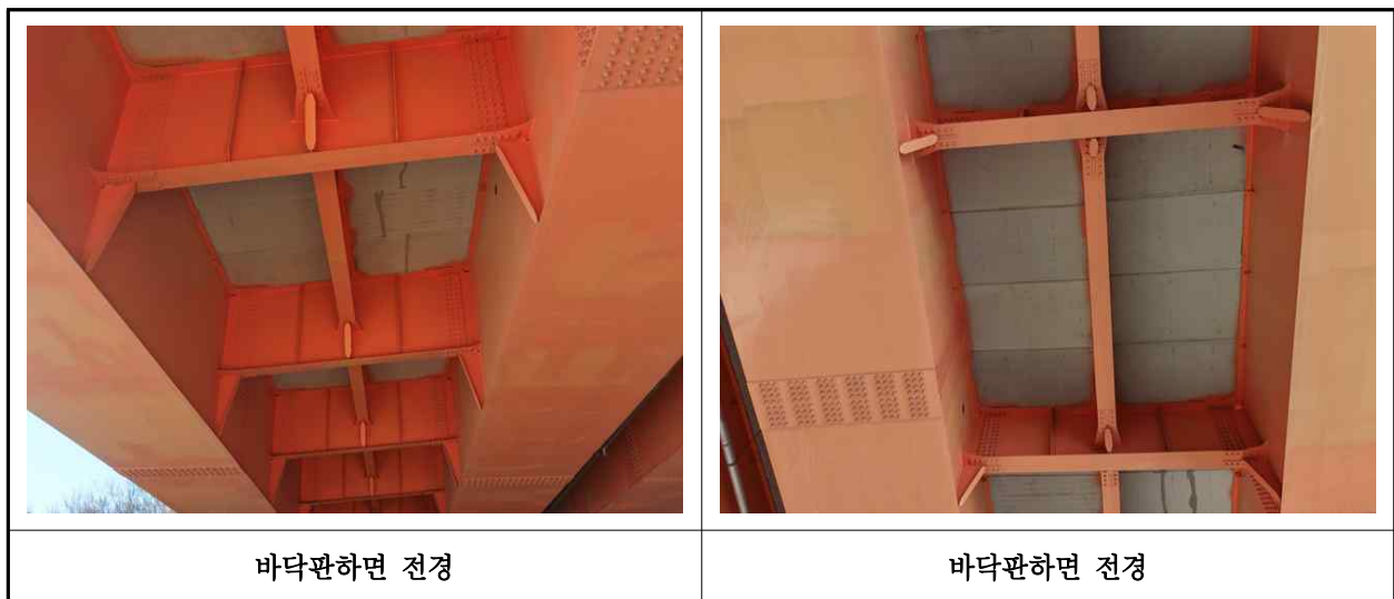
【사진 1.3.10】 바닥판하면 전경
