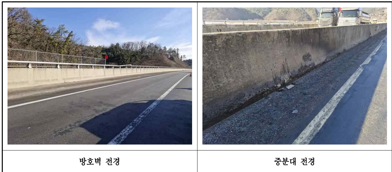
【사진 1.3.8】 방호벽 및 중앙분리대 전경
