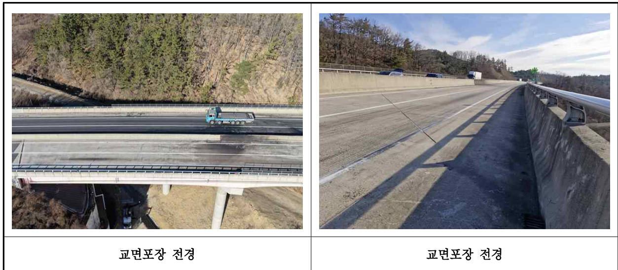
【사진 1.3.12】 교면포장 전경
