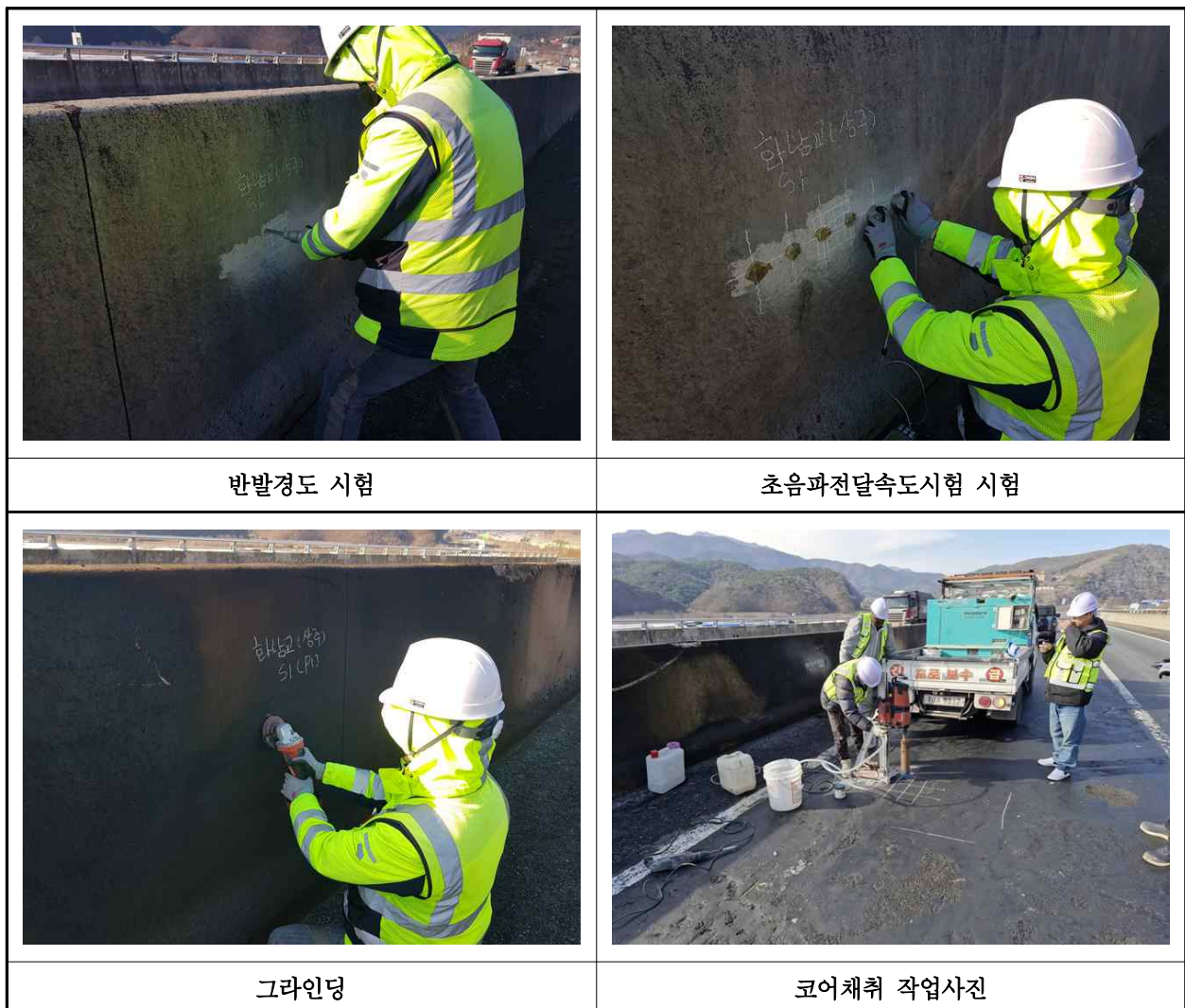
【사진 1.4.2】 반발경도시험 현장사진
