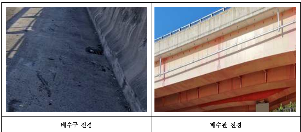
【사진 1.3.14】 배수시설 전경
