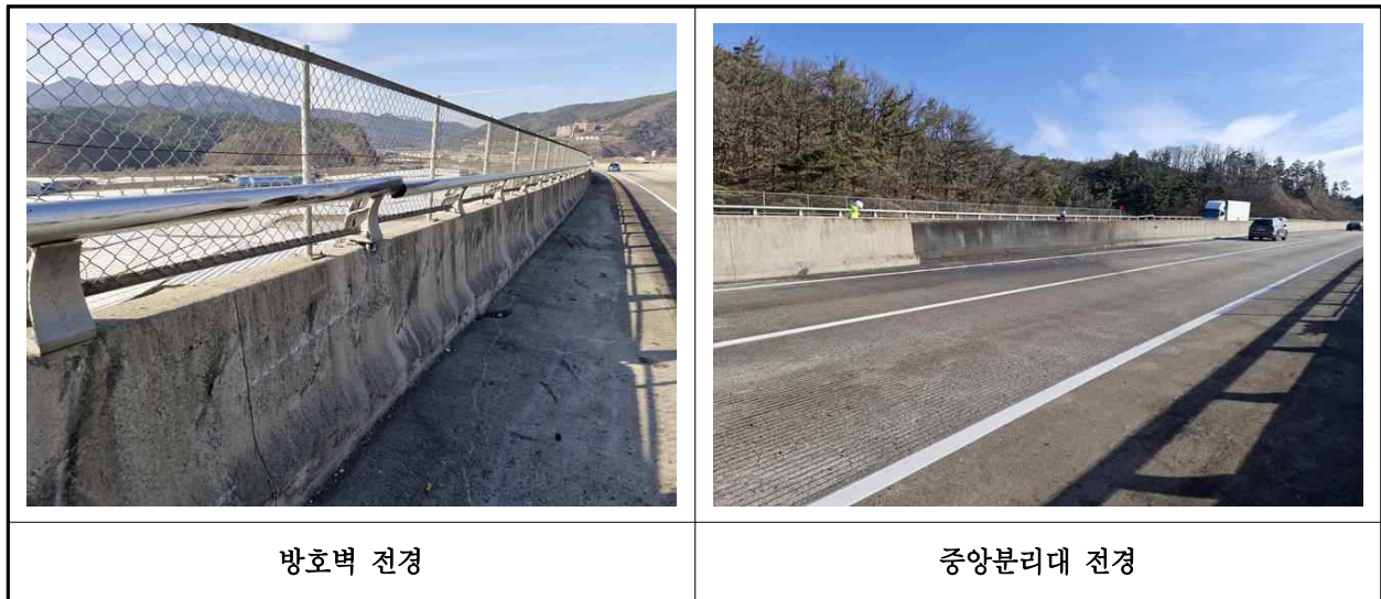
【사진 1.3.16】 방호벽 및 중앙분리대 전경
