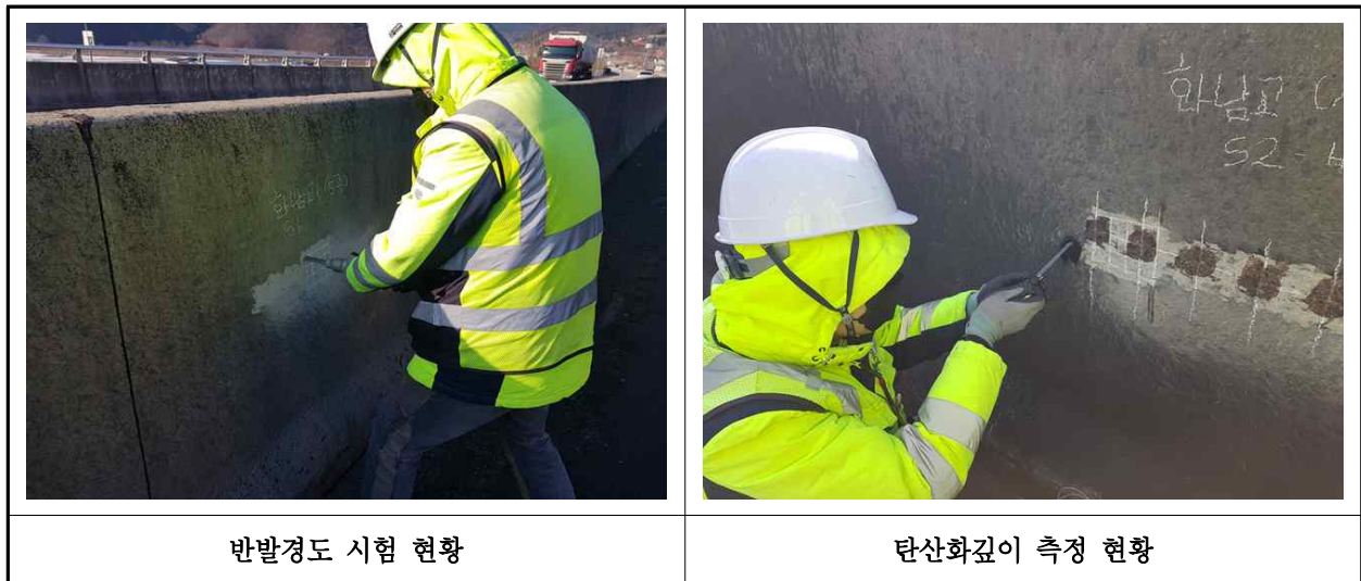
【사진 1.4.1】 콘크리트 내구성조사 현황
