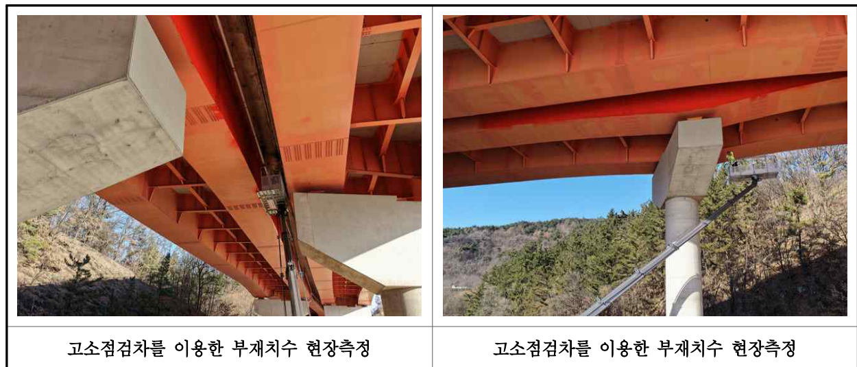
【사진 1.2.1】 부재 현장측정 전경
