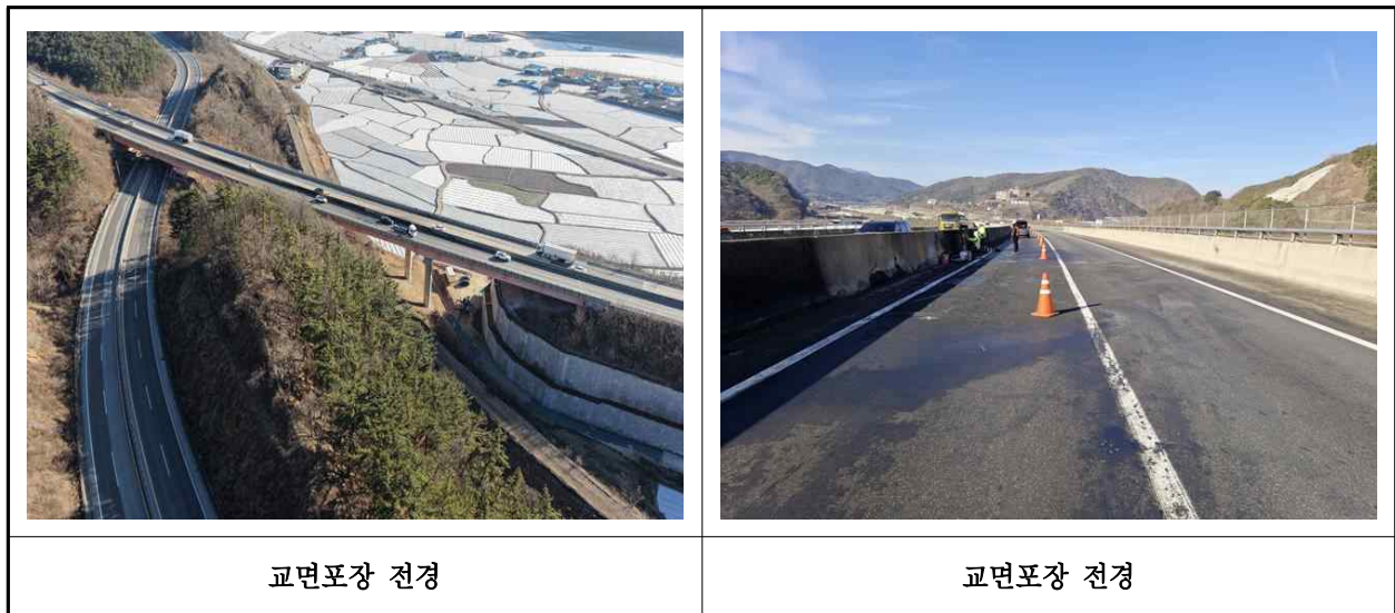
【사진 1.3.4】 교면포장 전경
